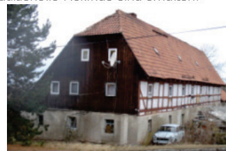
Dieses Fachwerkhäus war Teil eines großen Dreiseitenhofes und ist seit seinem Bau um 1800 fast unverändert erhalten. Der Hof hatte je ein Tor zur Dorf- und zur Dresdner Straße (B170). Das Haus ist trotz des schlechten Zustandes bewohnt.
